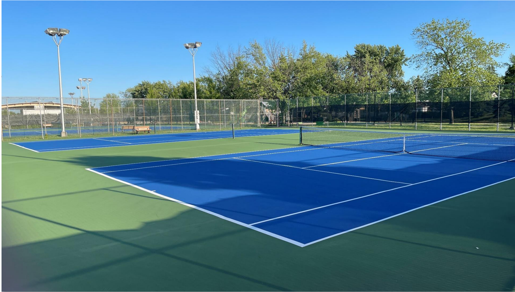
Réfection des terrains de tennis au Parc Marie-Victorin
