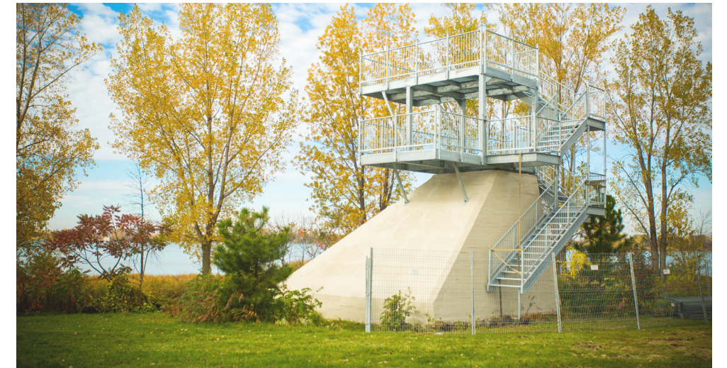
Belvédère construit sur un brise-glace
