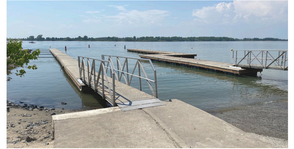
Rampe de mise à l'eau
